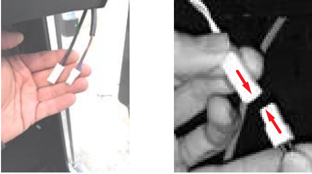
Şekil 7: LED çubuk: Kablonun bağlanması
