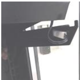
att. 8: Savienoto kabeļu iebīdīšana kabeļu kanālā
