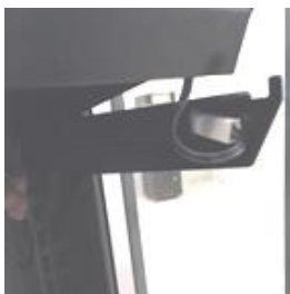
Obr. 8: Zasunutie spojených káblov do káblového kanála
