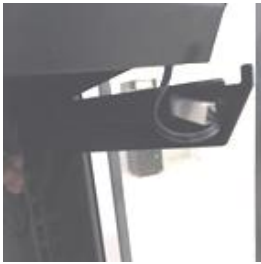
Pav. 8: Sujungtų kabelių įstūmimas į kanalą
