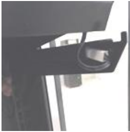
Abb. 8: Verbundene Kabel in Kabelkanal schieben
