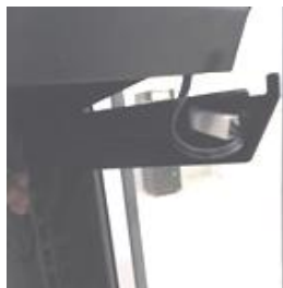
Rys. 8: Wsuwanie połączonych kabli do kanału kablowego
