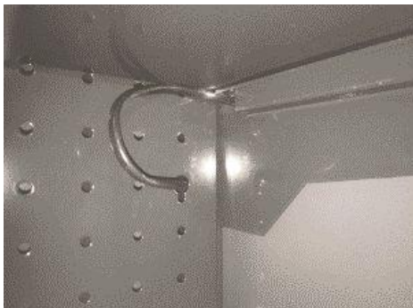
Joon 9: Kaabli paigutamine seadme tagaküljele
