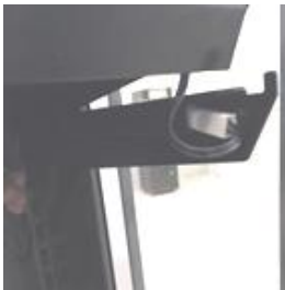
ábra 8: Az összekapcsolt kábelek kábelcsatornába tolása
