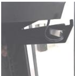
Joon 8: Ühendatud kaabli lükkamine kaablikanalisse
