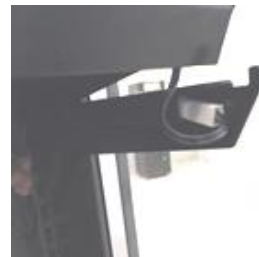
Fig. 8: Inserimento dei cavi collegati nella canalina
