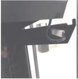
Şekil 8: Bağlı kabloların kablo kanalının içine itilmesi
