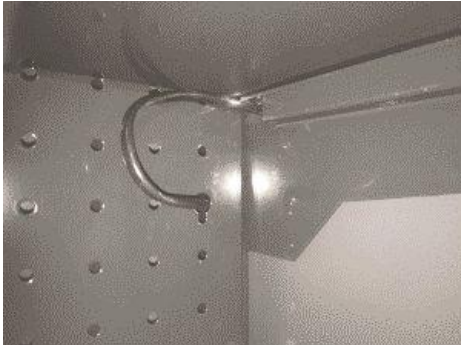
Pav. 9: Kabelio tiesimas prietaiso galinėje sienelėje
