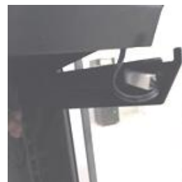
Fig. 8: Introducerea cablului conectat în canalul de cablu
