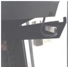
Sl. 8: Guranje spojenih kabela natrag u kanal za kabel
