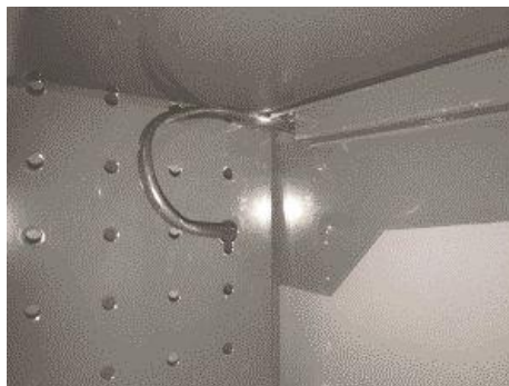
Rys. 9: Układanie kabla w tylnej ścianie urządzenia
