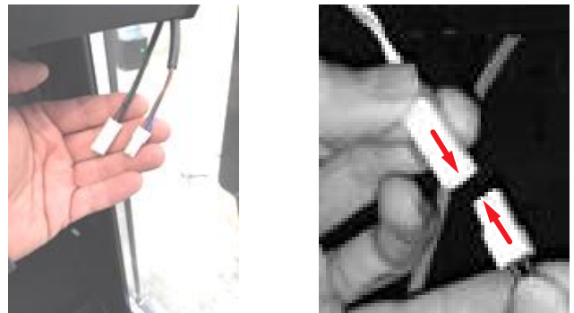
Fig. 7: Bara cu LED-uri: conectarea cablului
