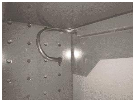
Fig. 9: Tender el cable en la pared trasera del equipo
