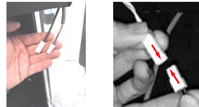
Εικ. 7: Ράβδος LED: Σύνδεση καλωδίων
