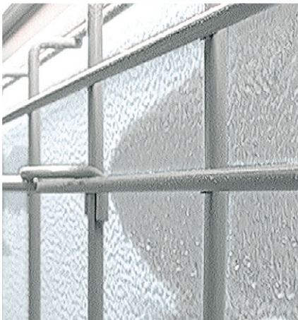
Schmelzen der Eisschicht während der Enteisung
